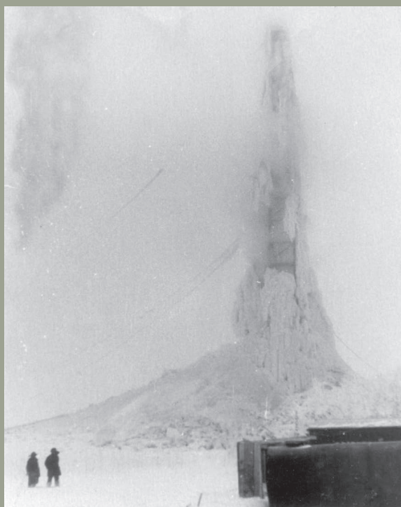
Аварийный фонтан на буровой Пахромского месторождения газа в Березовс- ком районе
